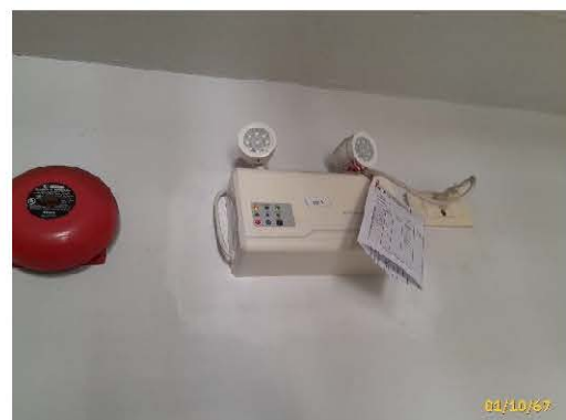
Battery ไฟฟ้าสำรอง
